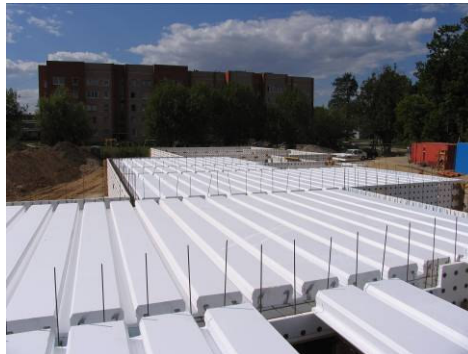
Dzīvojamās mājas un pārseguma izbūve izmantojot sistēmu DOBELES PANELIS
