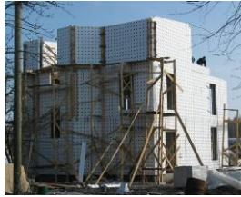
Dzīvojamās mājas un pārseguma izbūve izmantojot sistēmu DOBELES PANELIS
